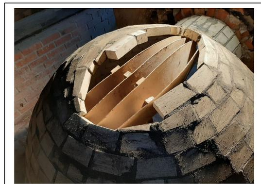
Nach Beendigung der Arbeiten für das innere feuerfeste Mauerwerk aus Schamottesteinen konnten die beiden äußeren Ringe aus den vom Abbruch gewonnenen Steinen gemauert werden.
