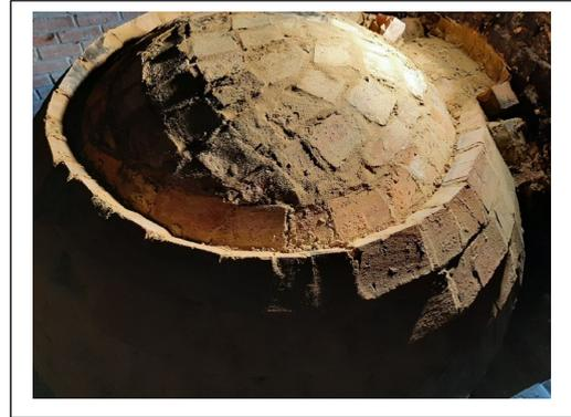
Nach Fertigstellung der Maurerarbeiten wurde eine äußere Dämmung aufgebracht. Diese besteht aus Perlit mit Zementmörtel. Perlit ist ein grob gemahltes glasartiges Gestein, aus der Aktivität von Vulkanen entstanden. Das Granulat besteht aus sogenanntem Blähperlit. Dieses entsteht durch schockartiges Erhitzen des Grundmaterials auf über 1000 Grad Celsius. Das im Stein enthaltene Wasser wird in diesem Zuge aufgebläht, sodass sich das Volumen bis auf das 20fache vergrößern kann.
